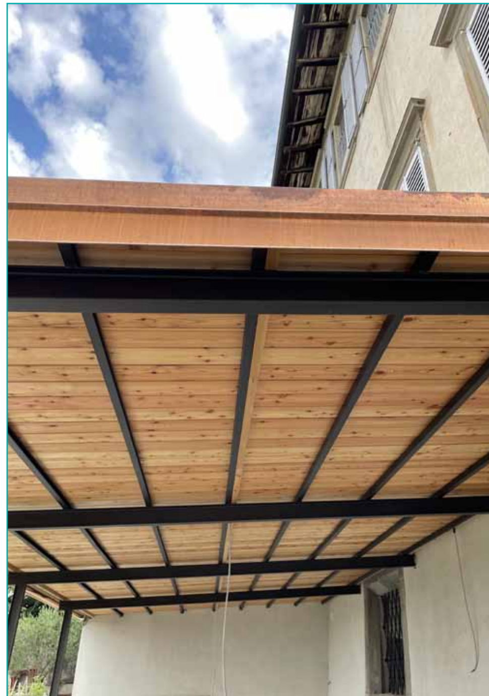
Tettoia con le nuove perline in legno
