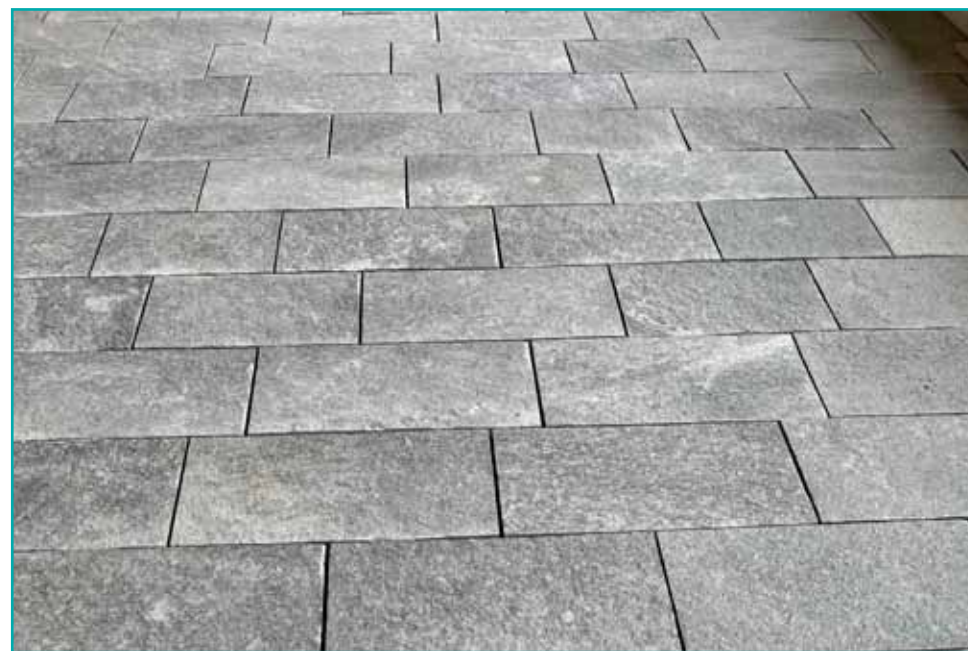
Particolare del nuovo pavimento in pietra di Luserna.
