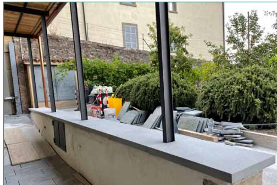
Muretto con le nuove copertine in pietra arenaria.
