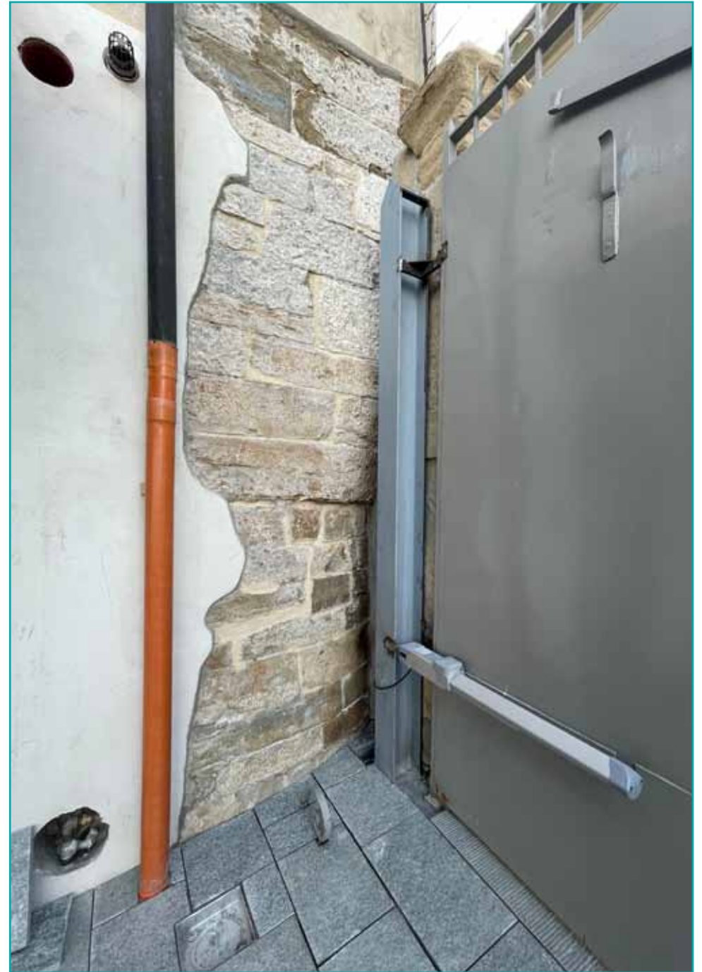
Torrione in pietra ripristinato allo stato originario.
