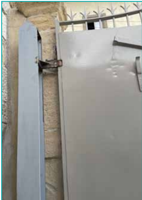
Cancello lato sinistro agganciato alla nuo- va struttura in ferro.
